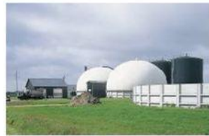
Blabjerg biogas plant, Denmark
