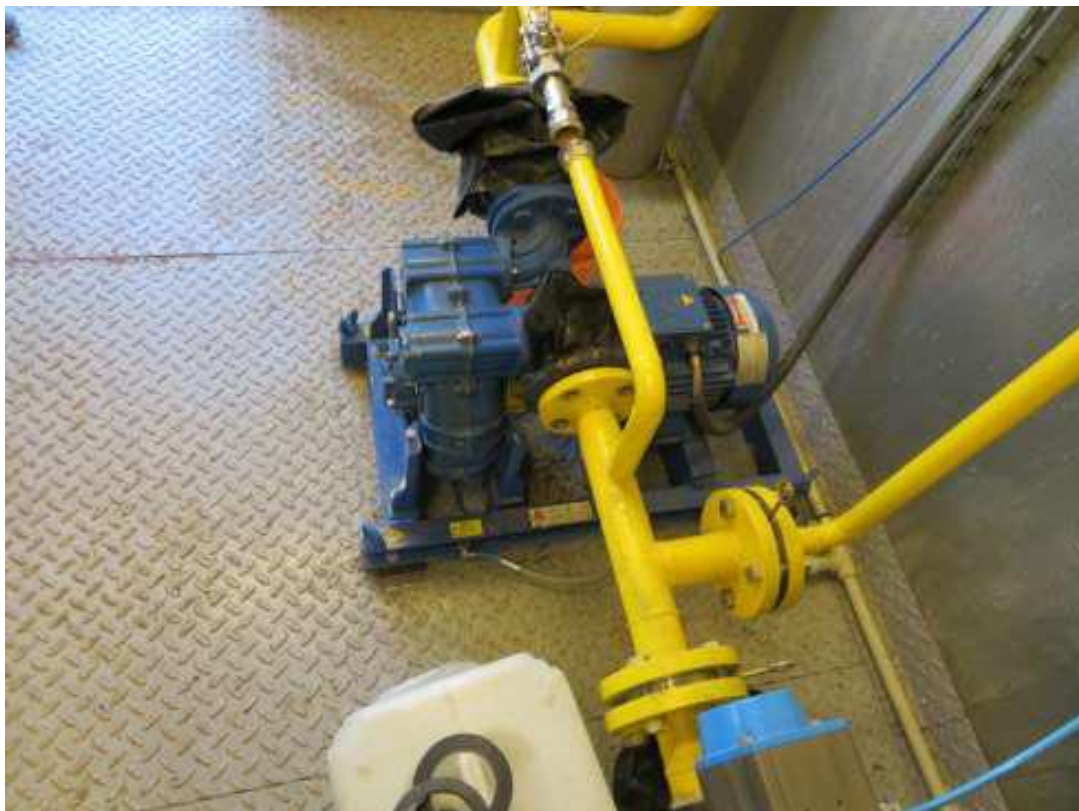
2. Silnik trójfazowy 4kW 1500 obr./min, przekładnia walcowa H061U
