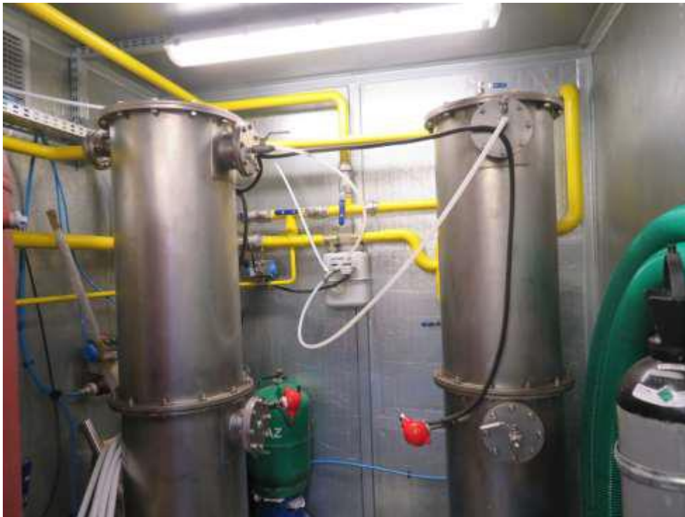
12 System MSMR-16 BIO - system Monitorowania Gazów MSMR-16 BIO przeznaczony jest do stosowania w profesjonalnych instalacjach do niezależnego pomiaru gazów z głowic pomiarowych.
