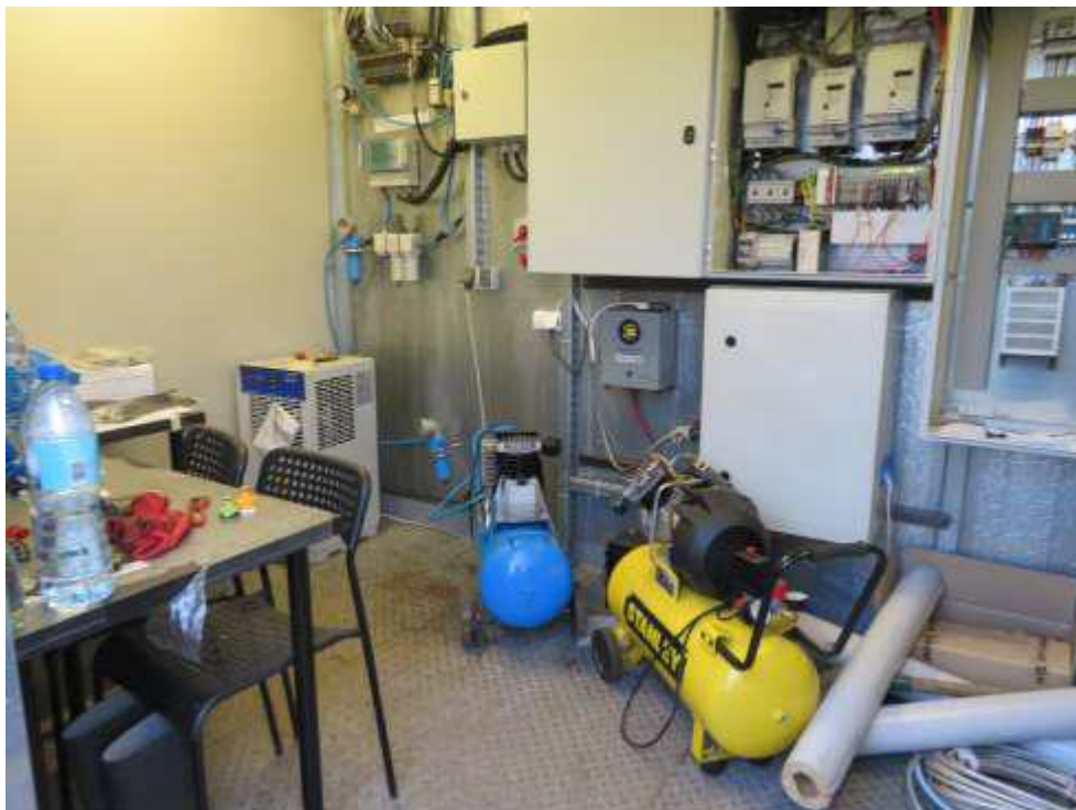
7. Zawory gwintowane + siłowniki, zawór kotłownicowy + siłownik
