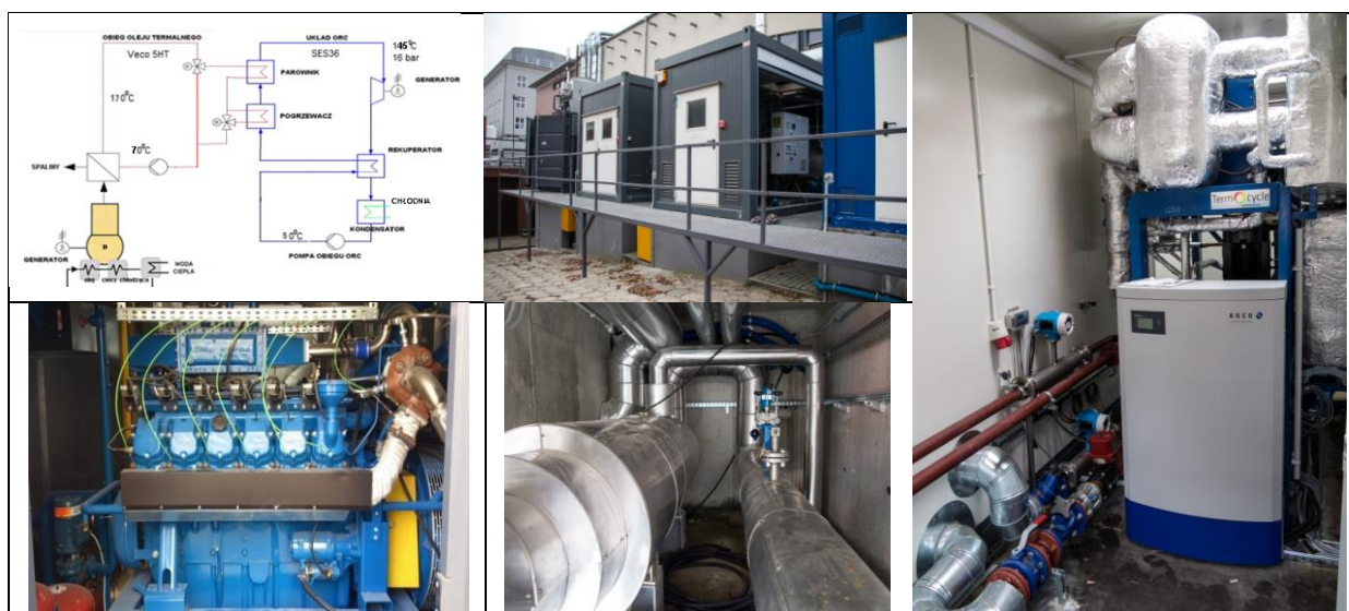
Schemat i elementy badawczego układu kogeneracyjnego gazowo-parowego w IMP PAN
