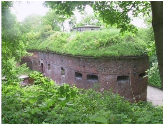
Kaponiera Południowa widziana od strony zachodniej
