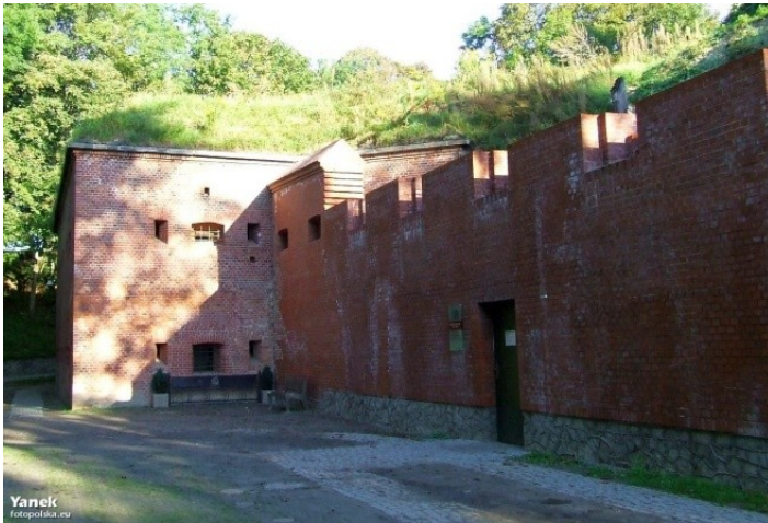
Kaponiera Południowa widziana od strony fosi suchej z kierunku wschodniego
