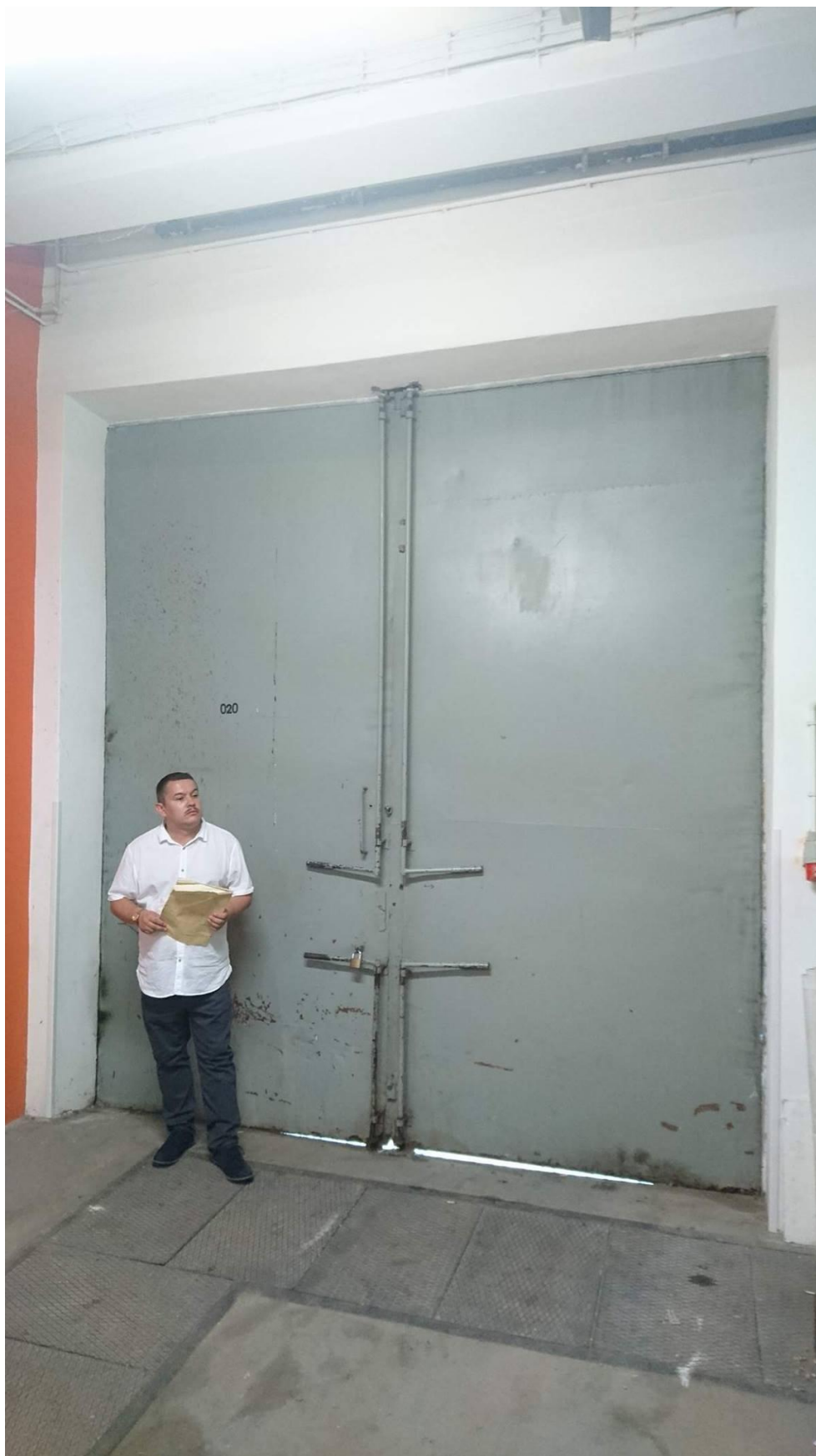
Zdj. 1 Brama wjazdowa
